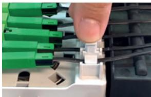
**4.4.3** Para a retenção do drop óptico, acomode-o na cavidade da trava-drop e pressione este para baixo.
