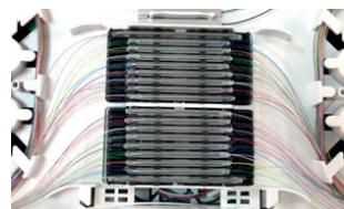
**4.2.4** A proteção das fusões deverá ser efetuada utilizando protetores de emenda de 45 e/ou 61 mm de comprimento (arame 1,2mm).
