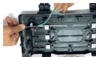
**4.1.4** Passe as abraçadeiras metálicas pela alça da reserva de tubo loose, em alinhamento com a entrada do cabo, conforme imagens, mantendo-as abertas.
