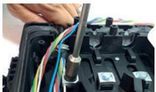
**4.1.6** Trave o elemento de tração, realizando o aperto do parafuso. Corte o excesso do elemento de tração do cabo.
