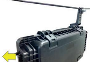
**4.5.3** Para a descida da caixa, afrouxe o conjunto prensa-cabo de um dos suportes poliméricos, levante a trava de segurança e, segurando a caixa, deslize este suporte afrouxado no sentido contrário da montagem. Logo, levante a trava do outro suporte, mantendo-o fixo na cordoalha, e desacople a caixa do suporte, para que esta fique livre para a descida.
