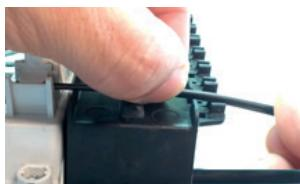
**4.4.4** Na parte do suporte para drop, localizado no bloco de vedação da entrada de cabos, insira o cabo drop na cavidade adequada, na posição em pé (vertical) e depois vire-o, fazendo a acomodação deste na posição deitada (horizontal).
