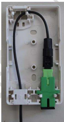
Conectorização em campo
