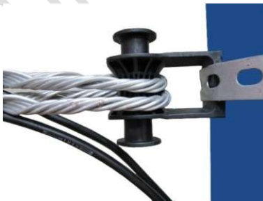
Ancoragem de dois cabos ópticos
