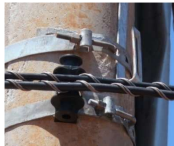
Sustentação de dois cabos óptico
