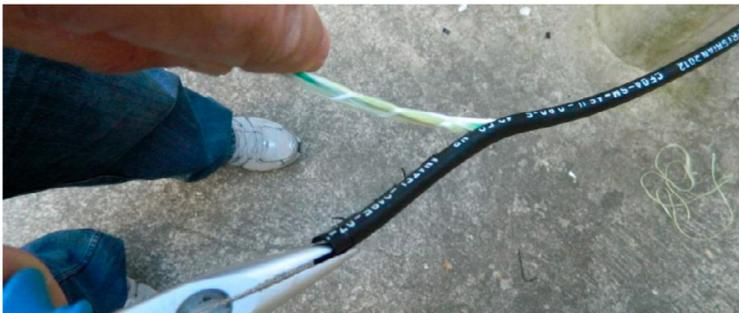
**13.** Fazer o acabamento entre capa e tubo loose com fita de alta fusão.
