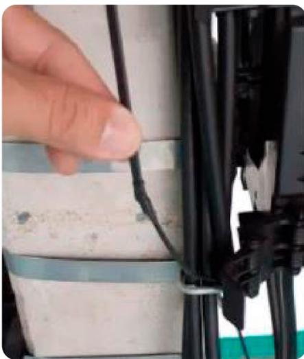
**7.** Instale fita isolante no corte do elemento de tração;
