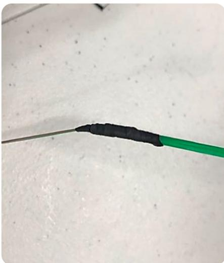
**1.** Aplicar auto fusão na extremidade dos tubos loose.
