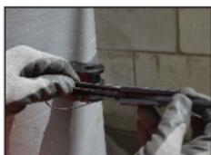
**3.2.** Em seguida, encaixe CORPO no drop e deslize-o no sentido do NÚCLEO travando o sistema.
