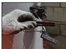
**3.1.** Fixar o gancho do SRDO no SDA, em seguida estique o drop até o ponto de fixação e coloque o NÚCLEO do SRDO neste ponto, segurando-o junto com o drop.
