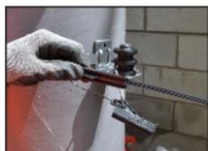
**4.1.** Fixar o gancho do SRDO na Roldana RP-2, em seguida estique o drop até o ponto de fixação e coloque o NÚCLEO do SRDO neste ponto, segurando-o junto com o drop.
