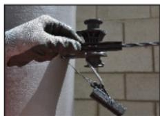
**4.1.** Fixar o gancho do SRDO na roldana no SCO, em seguida estique o drop até o ponto de fixação e coloque o NÚCLEO do SRDO neste ponto, segurando-o junto com o drop.
