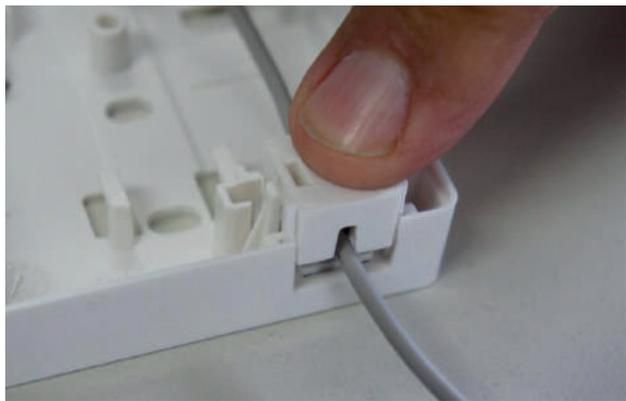
8. Feche o PTO colocando a tampa e aperte o parafuso. (Fig. 13)
