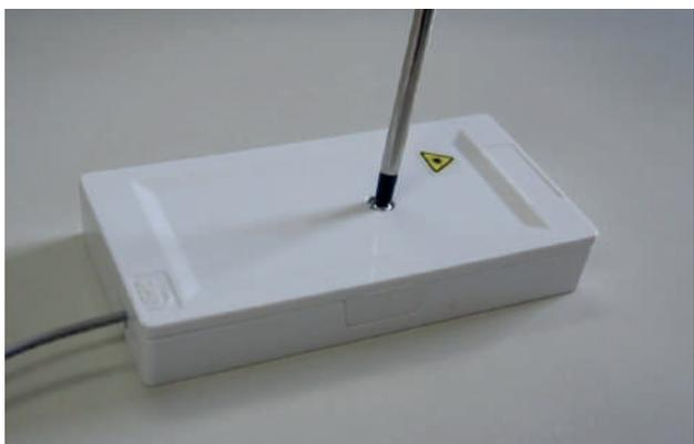
9. Fixe o PTO com os parafusos e buchas para finalizar a instalação. (Fig. 14)
