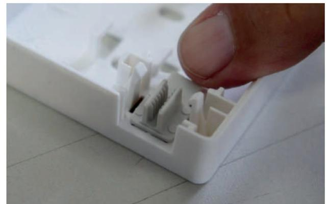
5. Recoloque a tampa cega no local onde foi retirada a trava do drop. (Fig. 10)
