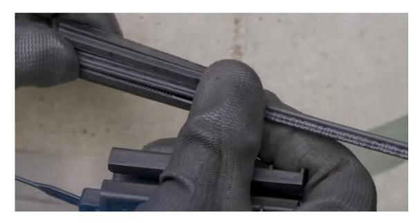
Estique o drop até o ponto de fixação e coloque o núcleo do SRDO neste ponto, sentido do núcleo, travando o sistema. segurando junto com o drop.
