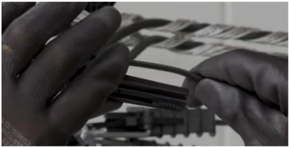
Estique o drop até o ponto de fixação e coloque o núcleo do SRDO neste ponto, segurando-o junto com o drop.
