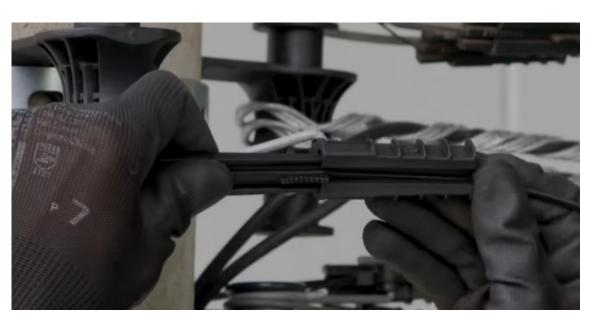
Encaixe o corpo no drop e deslize-o no sentido do núcleo, travando o sistema.
