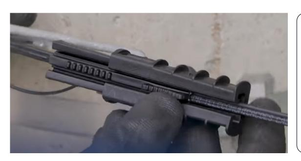
Pronto, o seu drop está perfeitamente encaixado dentro do corpo do SRDO e travado pelo núcleo.
